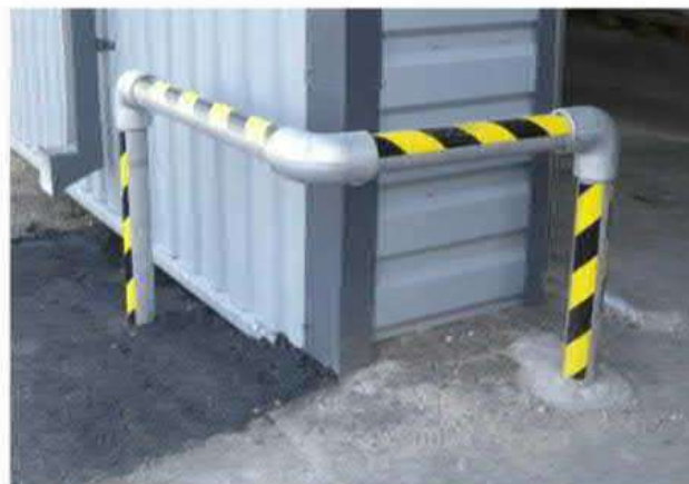
4.5 pav. Principinė kampinių atmušų schema
