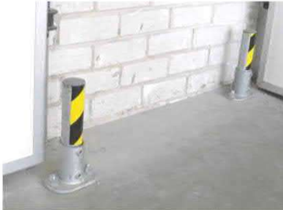
4.4 pav. Principinė stulpinių atmušų schema
